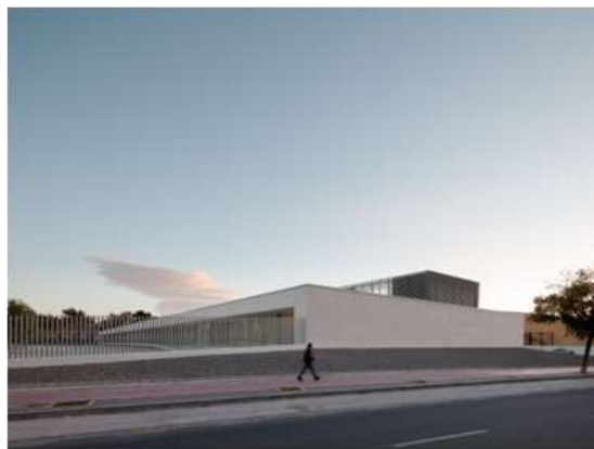
Figura 03: Fachada lateral esquerda do Centro
